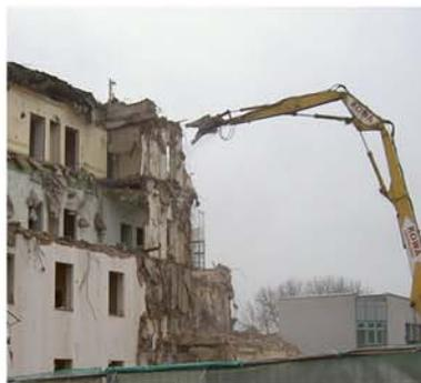
Abb. 3 u. 4: Abriss mit einem Bagger
