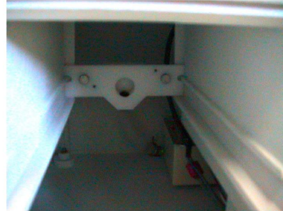
Abb. 10 Aufnahme der inneren Anschlussstelle für die Plastikwanne
